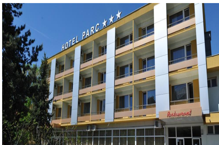
PLACARE CU POLISTIREN (TERMOSISTEM) ȘI TENCUIALĂ DECORATIVĂ ȘI PLACARE PARȚIALĂ A FAȚADEI CU ALUCOBEST - HOTEL PARC
