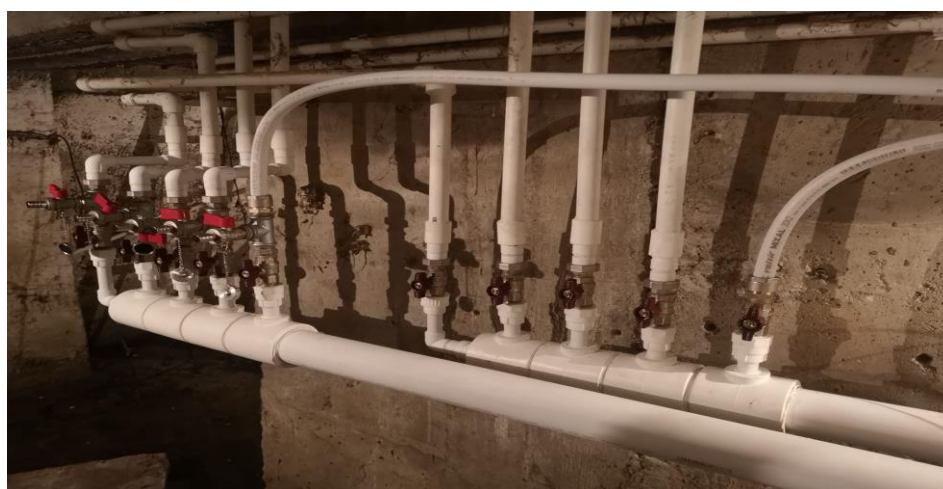
Investitie cladire Hotel Parc - inlocuire retea distributie incalzire la subsol
