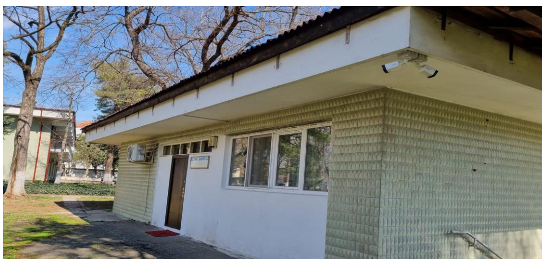
Sistem supraveghere birouri si Lucrari modernizare cladire birouri (tamplarie PVC+ usa metalica)
