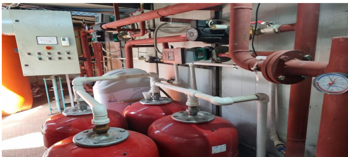
Lucrari instalare centrala termica (PT si executie lucrari de instalatii) - inlocuire centrala termica la Hotel Parc cu centrala tip baterie (4 buc)
