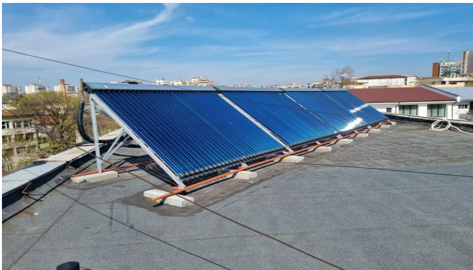
Lucrari de instalare echipamente pachet solar - montare panouri solare Hotel Parc
