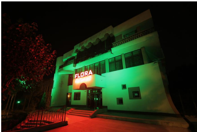
ILUMINAT DECORATIV PE FAȚADA RESTAURANT FLORA
